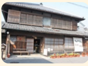
明治初頭の建築と推定される主屋は奇棟造り様瓦葺の屋根をもつ二階建ての建物。
